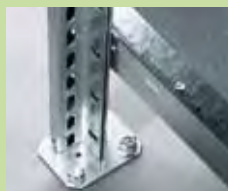
Riuli püstikraami kinnitus põrandaga, kui riulisüsteemi kõrgus ületab selle sügavuse rohkem kui 5-kordselt. Need riulid peavad olema ümberkukkumise eest kaitstud (kinnitatud seinaga või põrandaga).
