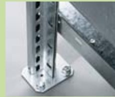
Riili püstikraami kinnitus põrandaga, kui riulisüsteemi kõrgus ületab selle sügavuse rohkem kui 5-kordselt. Need riulid peavad olema ümberkukkumise eest kaitstud (kinnitatud seinaga või põrandaga).
